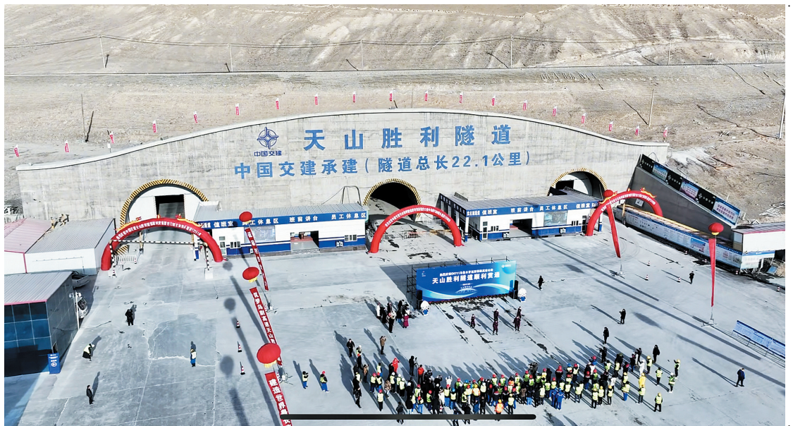
十二月三十日上午十一时,世界最长高速公路天山胜利隧道全线贯通。通车后,穿越阻隔新疆南北的天山峻岭仅需二十多分钟。图为隧道贯通仪式现场。兵团日报全媒体记者 邵明辉 摄
