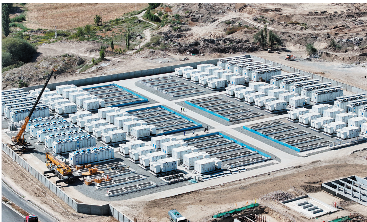
▲霍尔果斯经济开发区兵团分区300兆瓦/600兆瓦共享储能项目建设现场(摄于9月18日)。该项目总投资6.28亿元,建成后每年可供上网电量约120吉瓦时,将有效促进当地新能源消纳、提升园区电网运行的稳定性。 兵团日报常驻记者 杨俊钦 通讯员 郭思娜 摄
