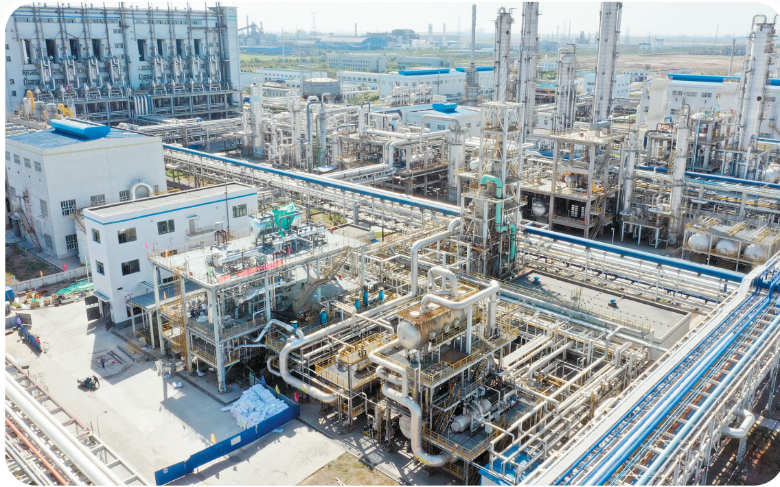
新疆新业能源化工有限责任公司硫回收系统升级和生产装置区VOCs治理设施更新项目鸟瞰图（摄于9月26日）。近年来，六师五家渠市深入贯彻落实绿色发展理念，积极打造培育兵团级绿色工厂，持续推动工业转型发展，让绿色低碳成为新型工业化最为亮眼的底色。 杜仪 朱小丽 摄
