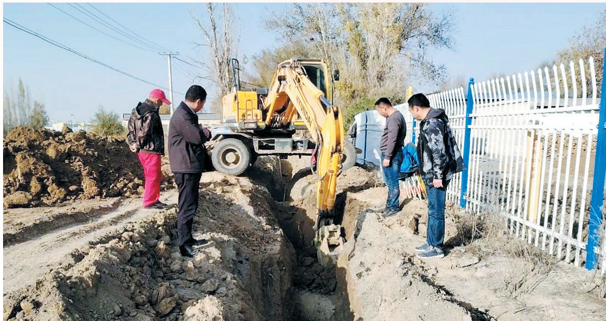
11月5日,在新湖农场三十二连户厕改造项目现场,工人们在施工。张静 摄
