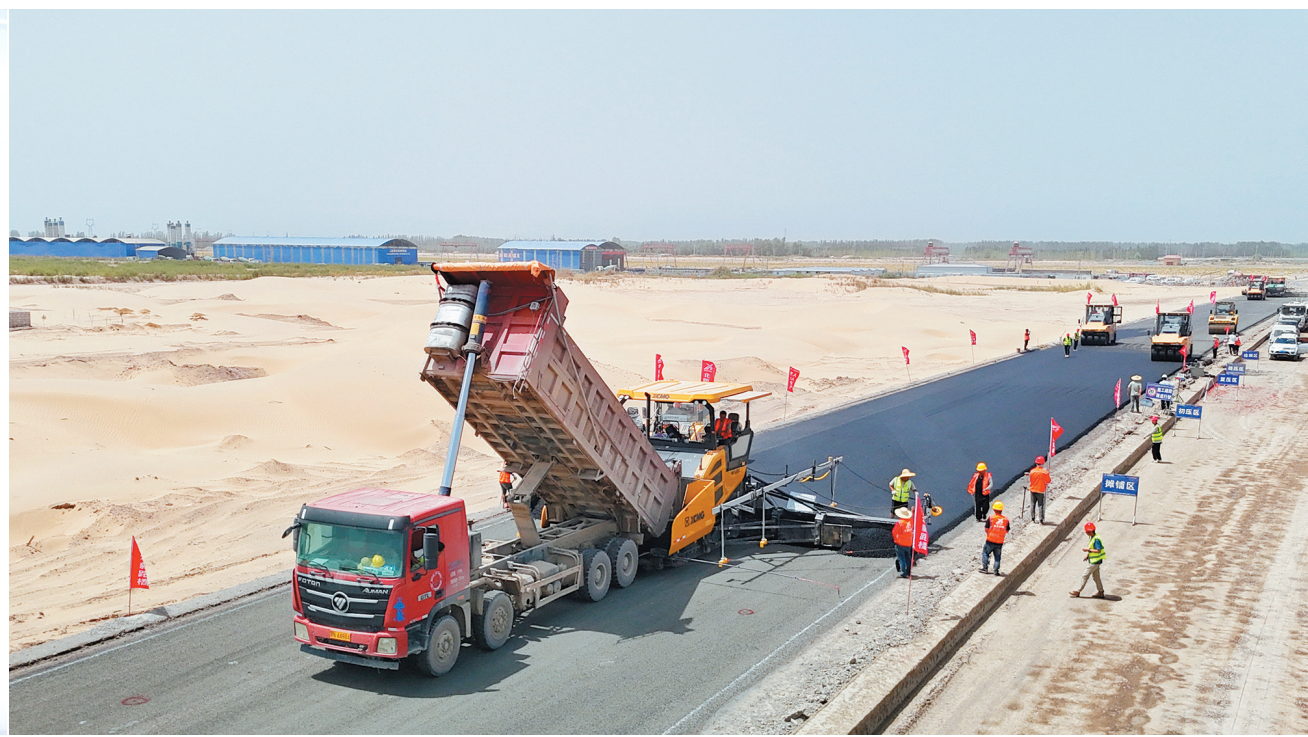
▶G3036阿克苏至阿拉尔高速公路项目二标段施工现场(摄于7月8日)。该标段沥青路面下面层试验段摊铺作业已全部完成。阿阿高速公路全长129.828公里,建设总投资56.64亿元,是兵团主导修建的首条高速公路,目前施工进度达65%。
