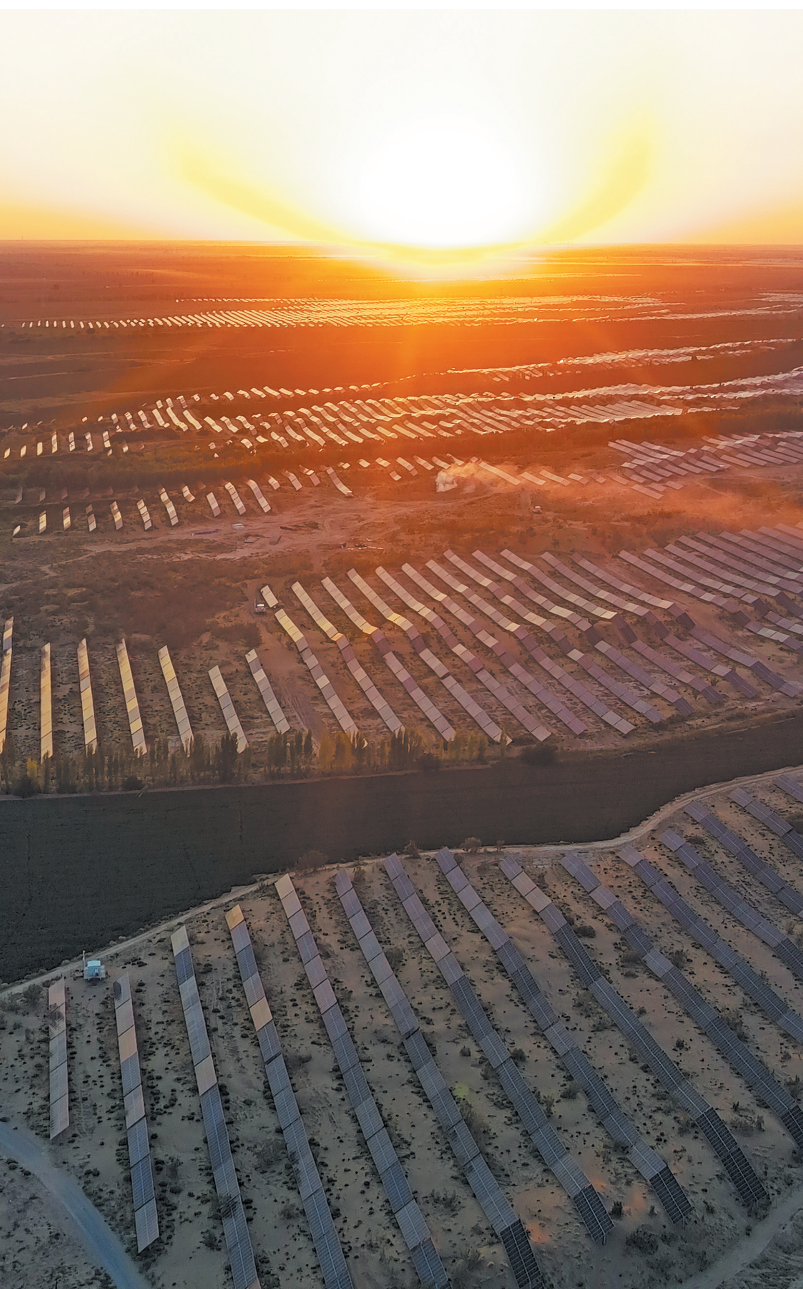
▼航拍的中新建石玛兵地融合2吉瓦光伏基地一隅(摄于8月31日)。当日,由新疆兵团建安工程建设有限公司承建的石玛兵地融合2吉瓦光伏基地项目二标段、四标段119个箱变、17条回路全部顺利并网送电。该项目是新疆首个兵地融合光伏防沙治沙项目,总投资约189亿元,创新采用“光伏板阵列间微地形集水”“草方格沙障+耐旱植被立体固沙”等技术,可有效改善生态环境,投产后每年可提供47亿千瓦时清洁电能。兵团日报全媒体记者 王志清 摄
